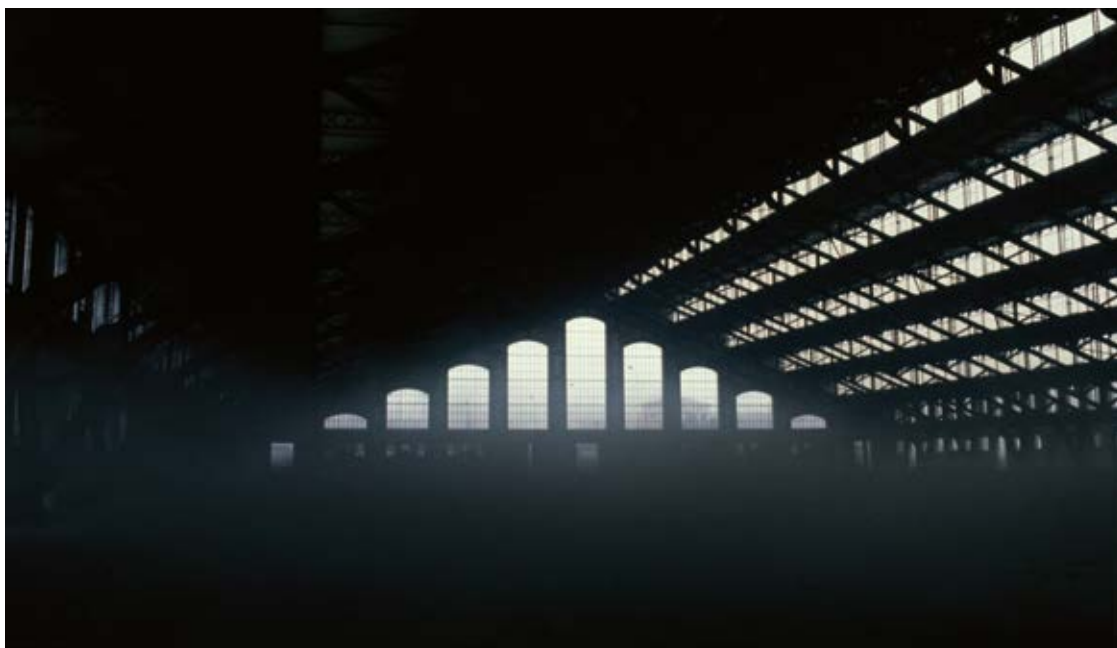
La halle Tony Garnier vers 1981, lors des travaux de réhabilitation
